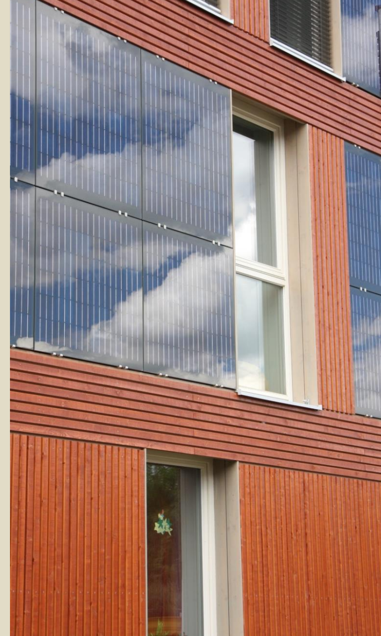
PV-Fassade Baugemeinschaft „elementar“, Tübingen, Foto T. Gauggel
